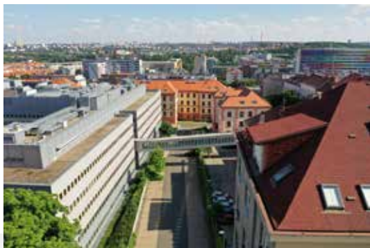
výhled do vnitrobloku
