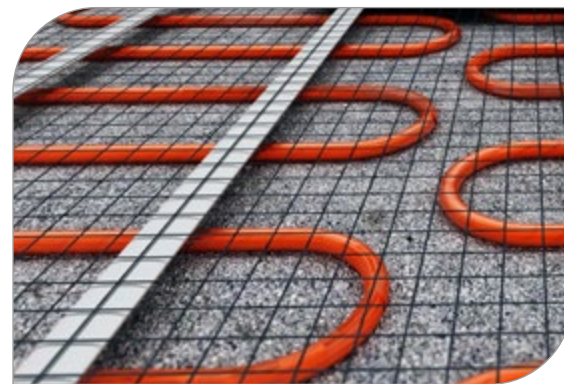
podlahové topení | underfloor heating
