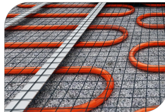
podlahové topení | underfloor heating
