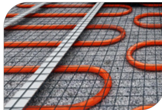
podlahové topení | underfloor heating
