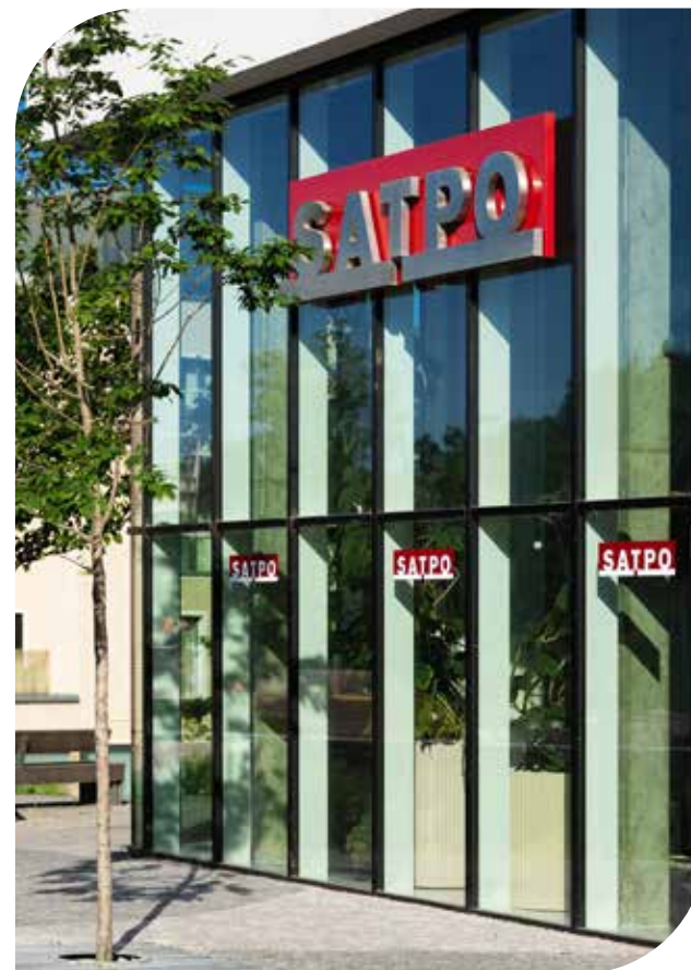
sídlo společnosti SATPO | office of SATPO
